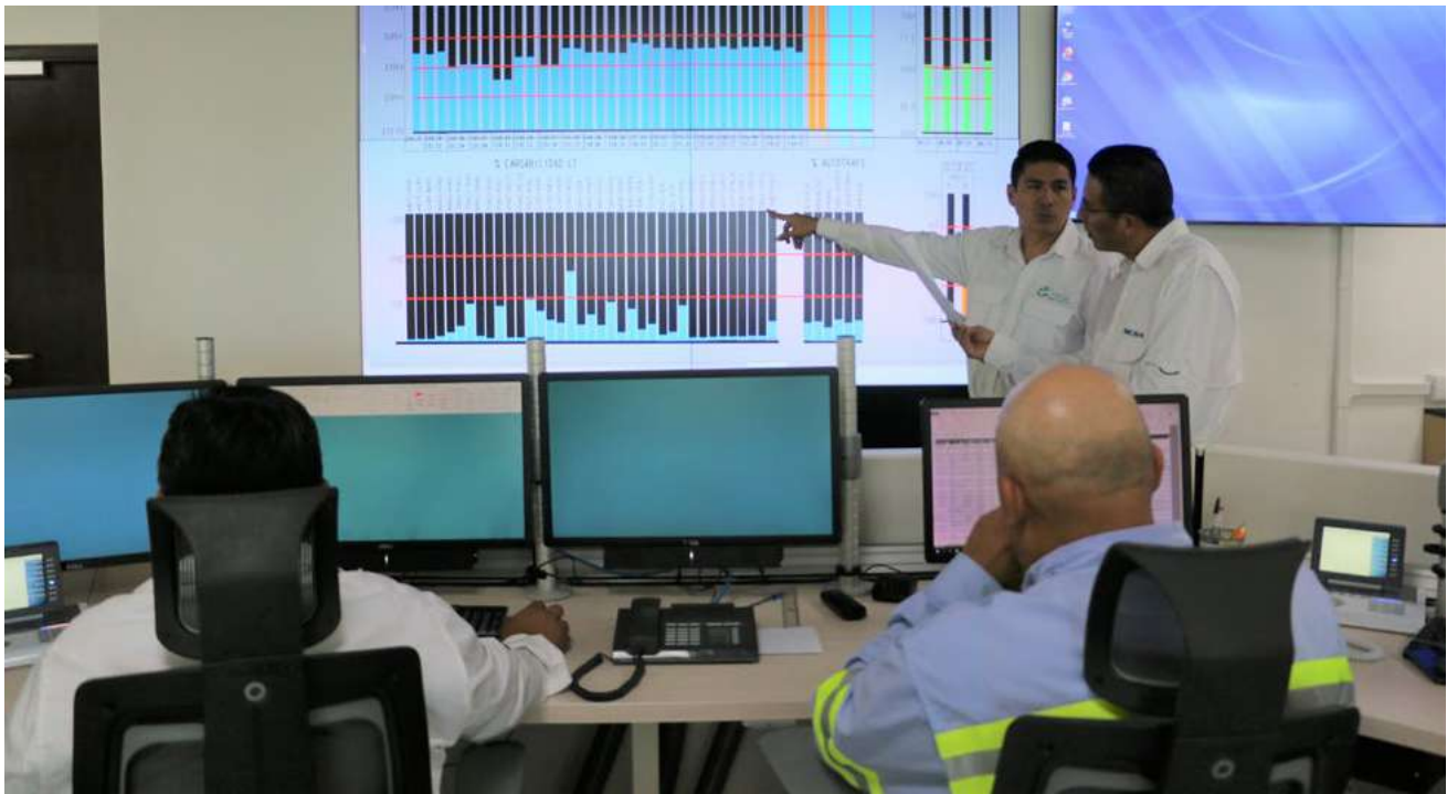
Centro de Control de Trecsa
