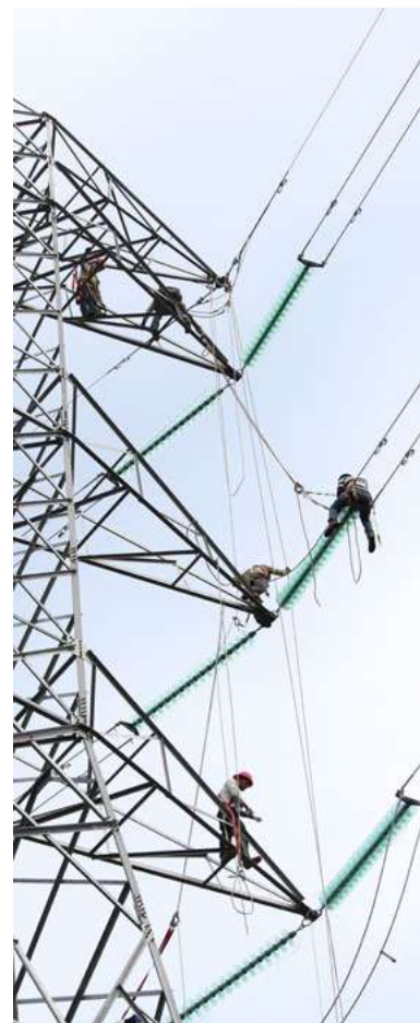
Trabajos en líneas de transmisión
