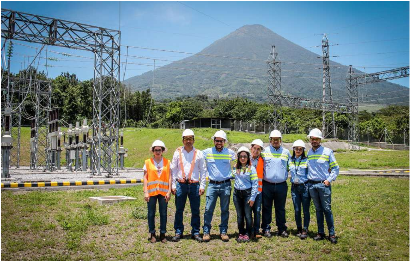
Colaboradores de Trecca en Subestación Palestina
