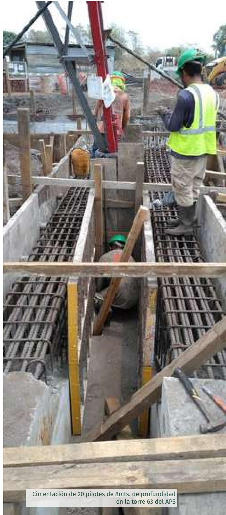
Cimentación de 20 pilotes de 8mts. de profundidad en la torre 63 del APS
