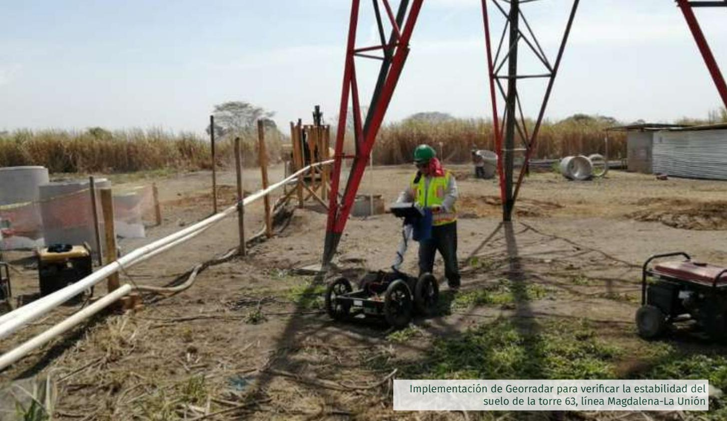
Implementación de Georadar para verificar la estabilidad del suelo de la torre 63, línea Magdalena-La Unión
